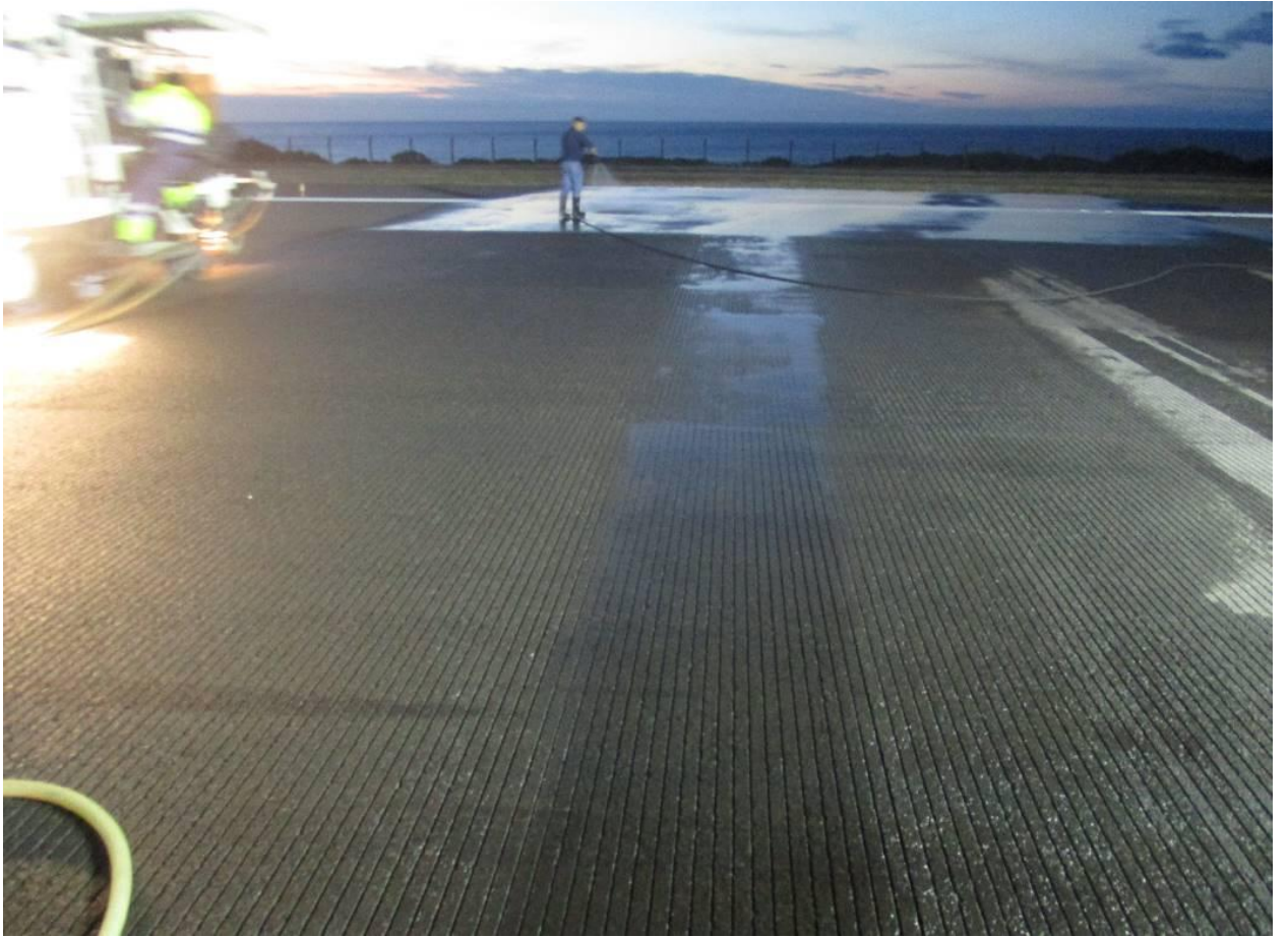
Fotografia 03 - Limpeza da Ranhuragem a Jato de Água
